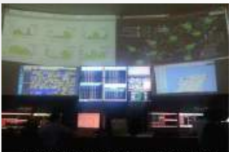
Centro de Control de Distribución, Yucatán.
