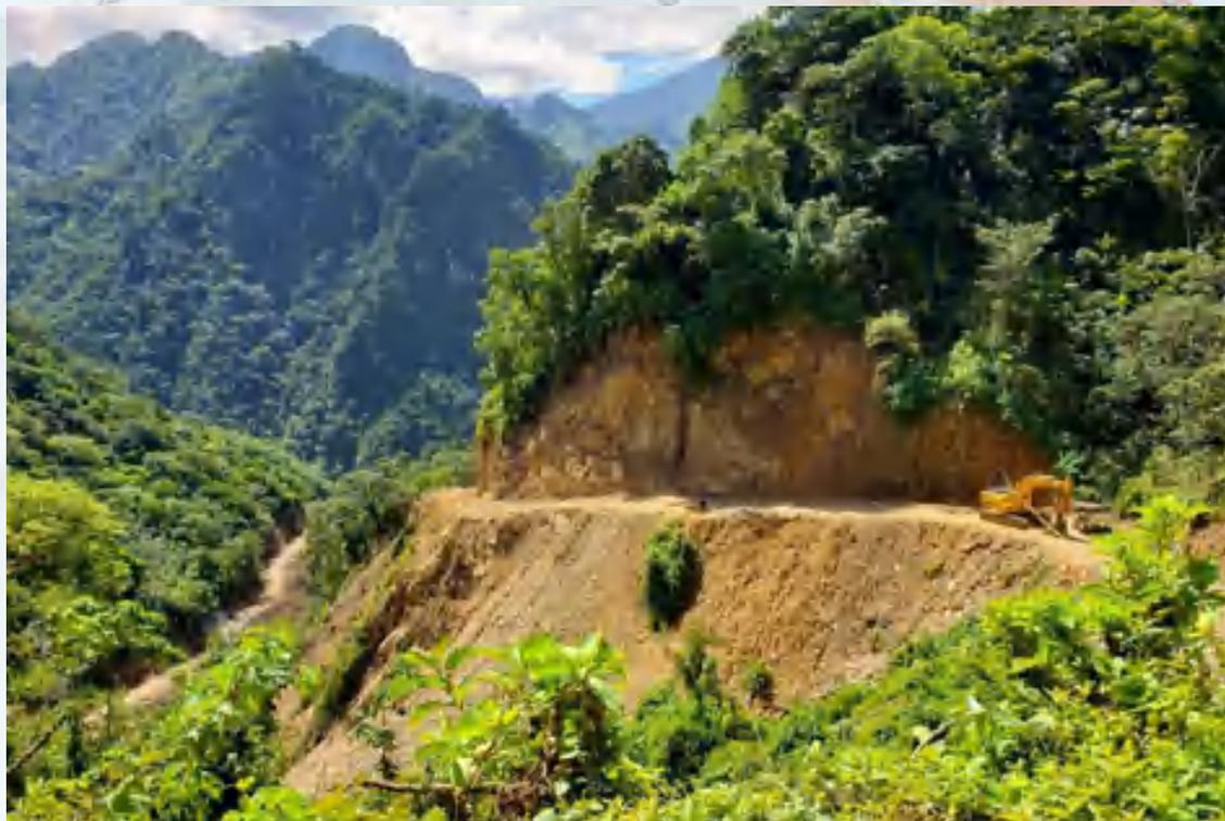
Figura 16. Corte de talud para la construcción de un camino en zona de alta pendiente.
